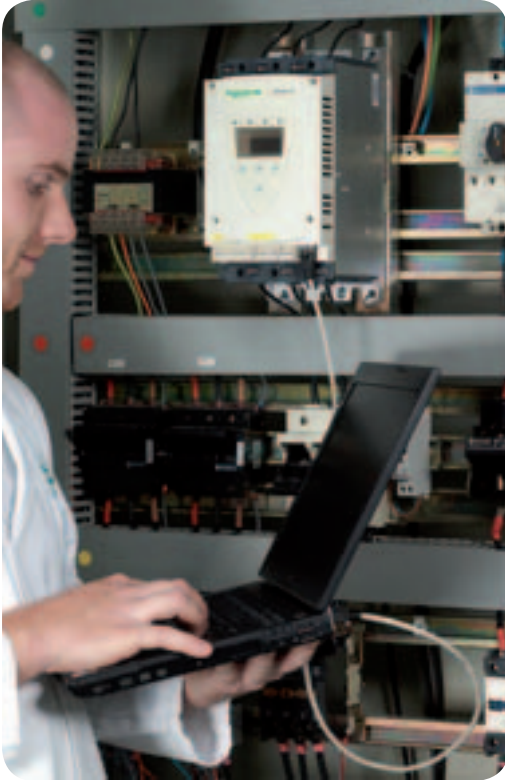
采用SoMove lite设置软件对ATS 22软启动-软停止单元进行配置
